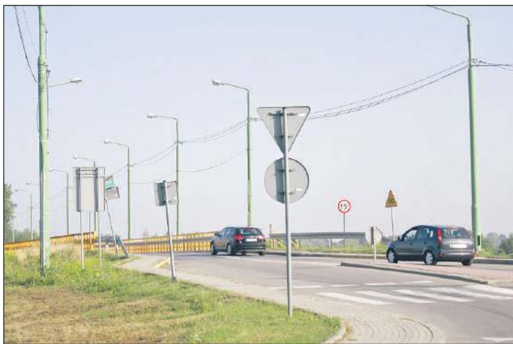
Nowy most na Wisłocze zbudowany zostanie po lewej stronie obecnego.
