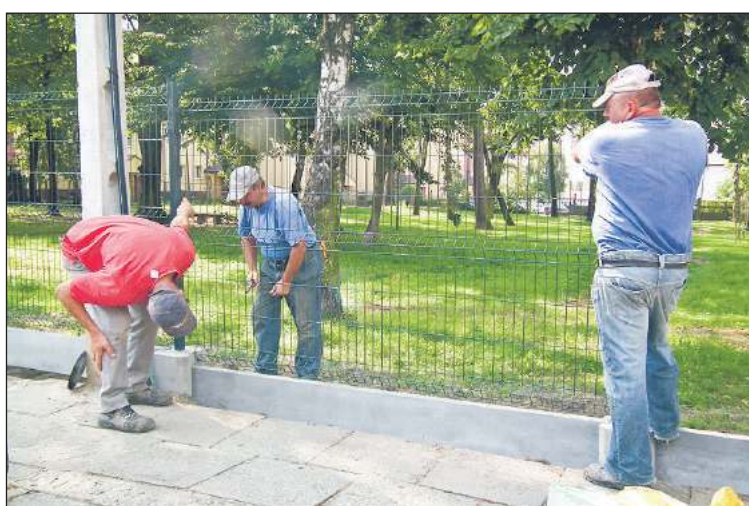
Ogrodzenie wymienione zostało w zeszłym roku.
