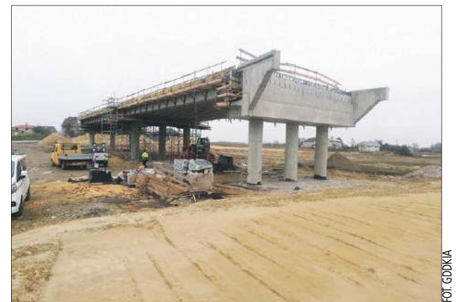
Na odcinku Swory – Biała Podlaska praca wre. Mieszkańcy chcą wiedzieć, co z odcinkami, przebiegającymi przez gminę Międzyrzec Podlaski
