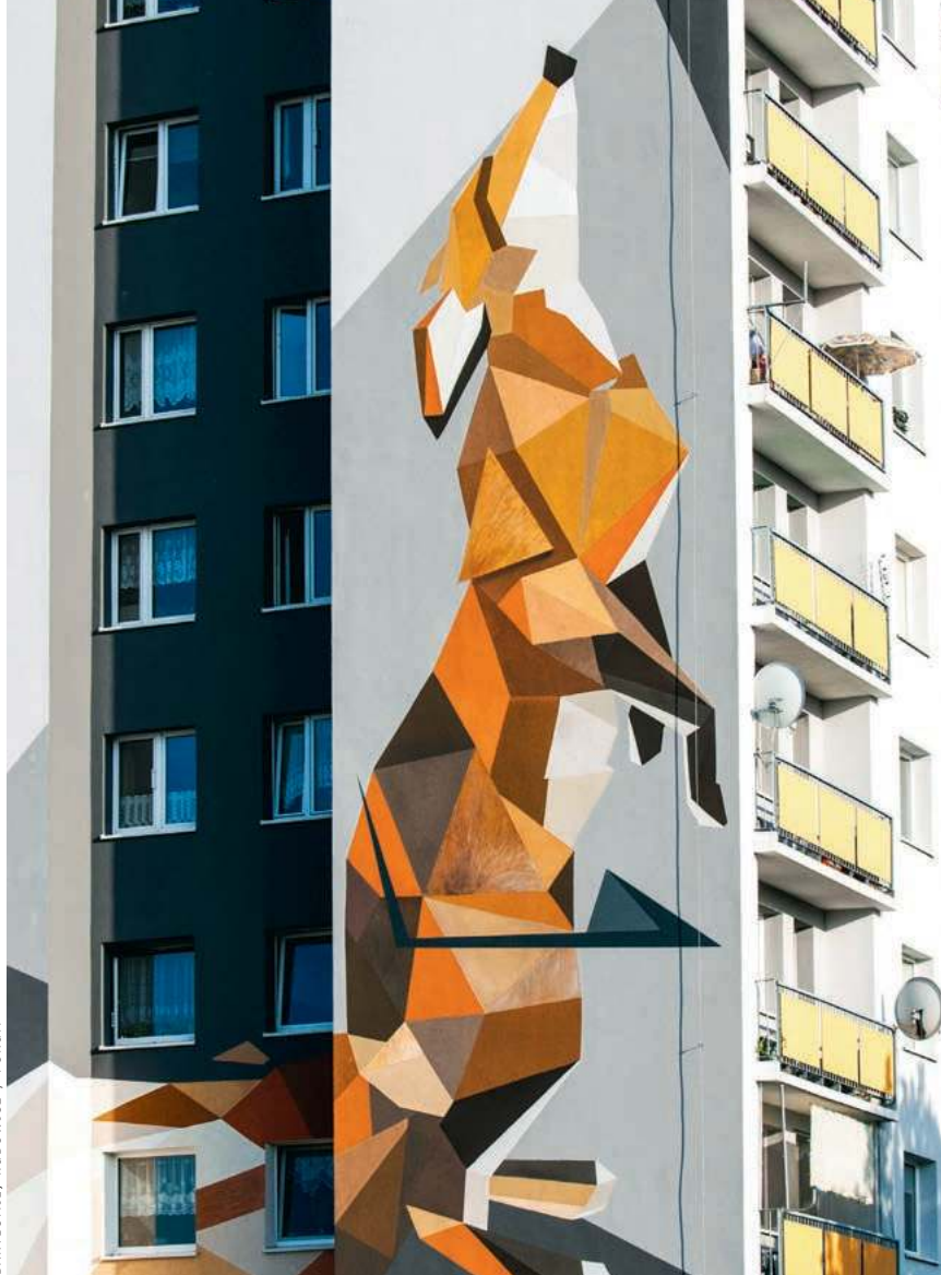
Po termomodernizacji – ulica Lisia w Zielonej Górze, 2019 r.
