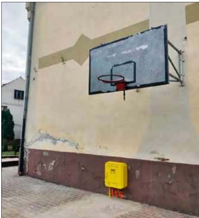
Skrzynka została zamontowana prawie na środku boiska.
