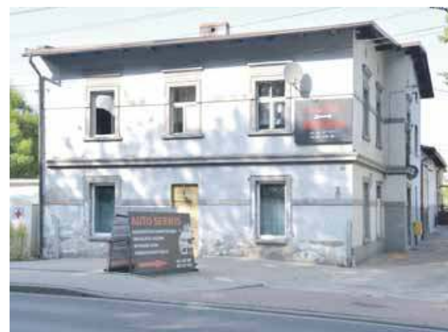
Budynek przy ul. Głównej – kiedyś działała tu restauracja, w której urządzano potańcówki
