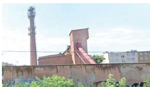
PEC planuje rozebrać budynek starej, nieczynnej kotłowni
