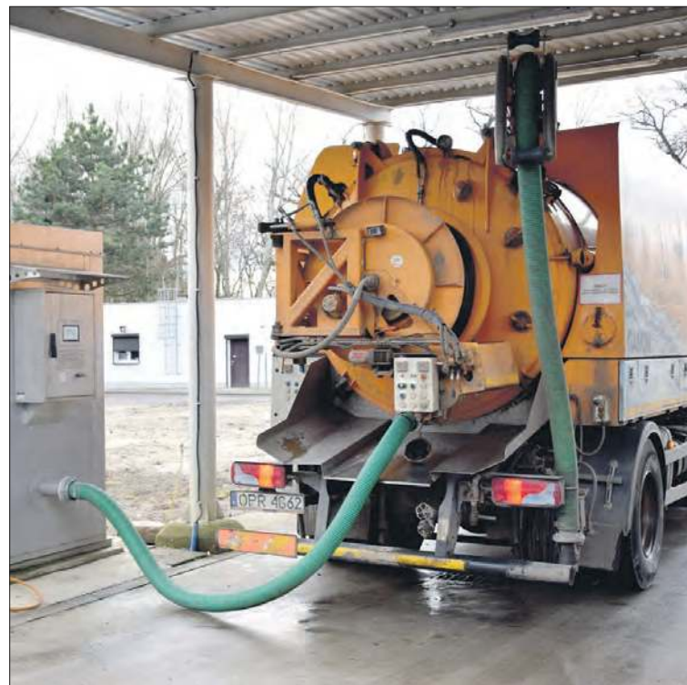
Odnowa oczyszczalni pozwoli podłączyć do niej kanalizację kolejnych miejscowości
