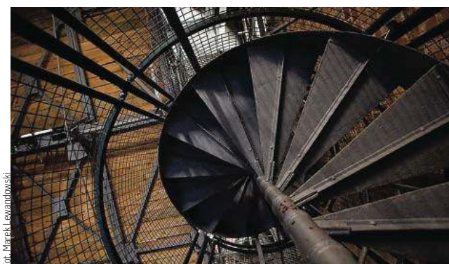
Na taras widokowy prowadzi 366 schodków
