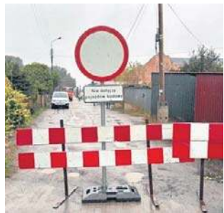
Ulica Gniewkowska będzie przebudowana na długości około 600 metrów
