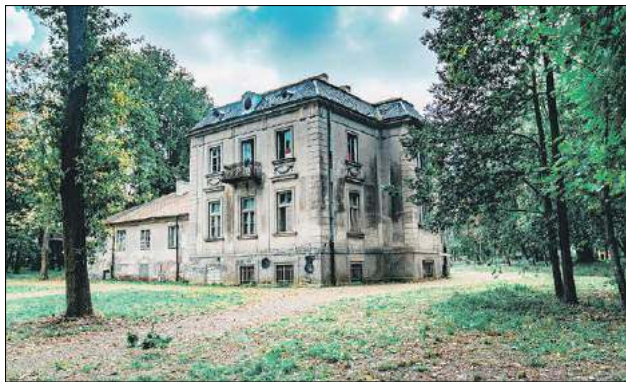
Przedmiotem inwestycji jest wykonanie wieloetapowego projektu wielobranżowego remontu, przebudowy i rozbudowy zabytkowego dworu w Woli Osowińskiej w gminie Borki w oparciu o autorską koncepcję już zatwierdzoną przez UKZ
