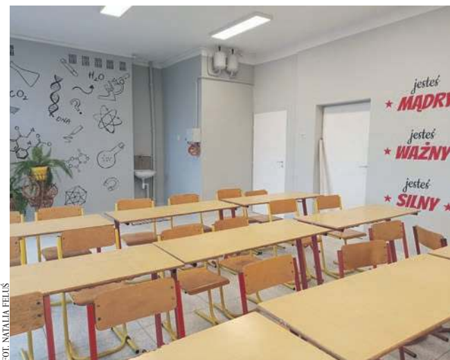
Efekt końcowy po remoncie
