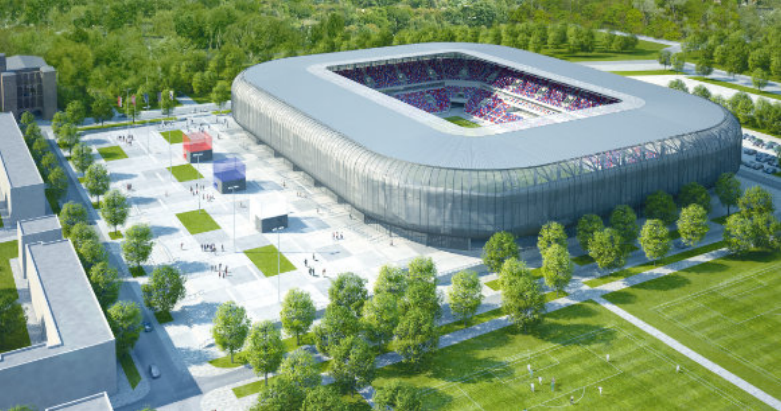
► Tak będzie się prezentować Arena Zabrze po zakończeniu prac Fot. UM Zabrze
