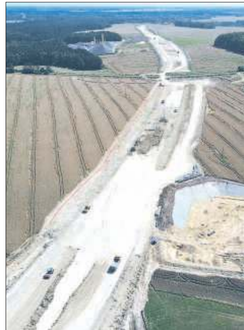
Prace na 125-kilometrowym odcinku z Piask do Hrebennego zostały podzielone na dziewięć etapów. Fot. GDDKiA
