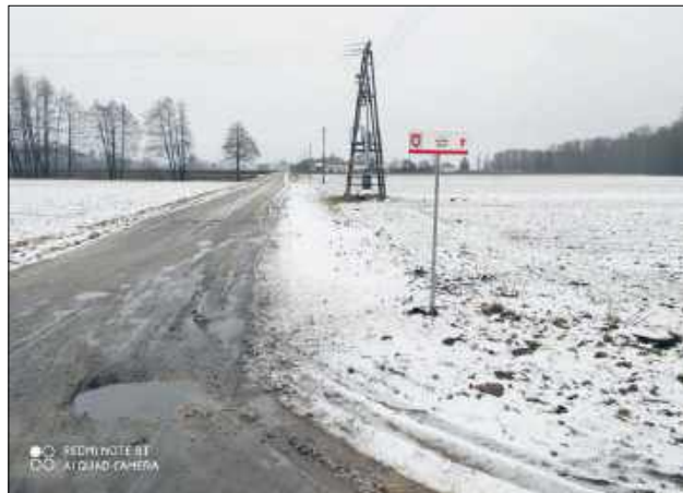
Remontowanych będzie pięć odcinków dróg, za kwotę 9 mln zł, w tym ul. Nowa w Drełowie
