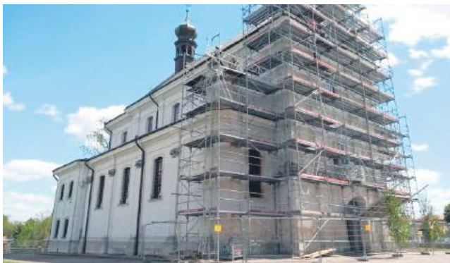
Obecnie przy świątyni wykonywane są prace konserwatorskie.
