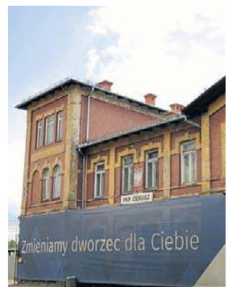
Dworzec w Olkuszu przejdzie kompleksowy remont
