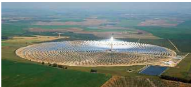
Fotografia 2. Elektrownia słoneczna Gemasolar skupia światło słoneczne na umiejscowionym na szczycie wieży zbiorniku ze stopioną solą, który jest termalnym magazynem energii, wytwarzającym parę wodną pod ciśnieniem dla turbin napędzających generatory
