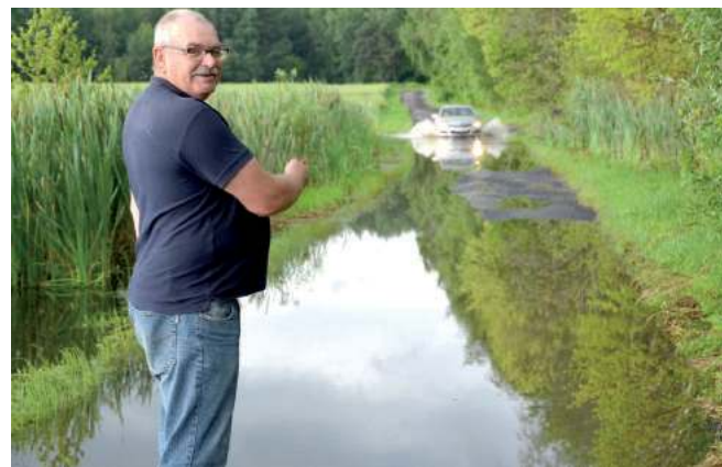
Po drodze gminnej nr 105 159L w Dratowie samochody suną powoli, generując fontanny wody i fale, jak motorówki na jeziorze
