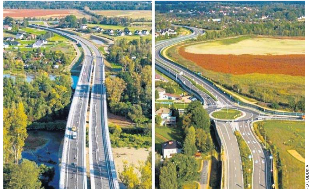
Obwodnica Oświęcimia gotowa jest na ponad 90 procent. Trwa budowa kluczowej części inwestycji przejazdu pod linią kolejową
