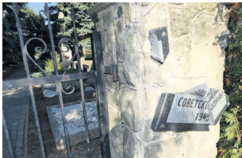
Potraskane i wiszące fragmenty tablic przy wejściu na teren radzieckiego cmentarza widoczne są już z kilku metrów
