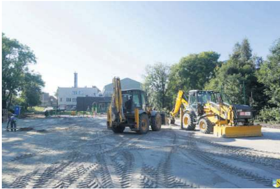
Prace przy budowie boiska wielofunkcyjnego w Białym Kościele idą pełną parą. Foto: UMiG Strzelin
