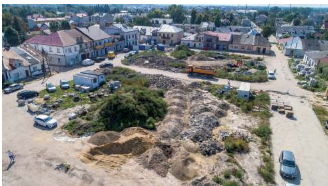
Rynek II i jego otoczenie było do niedawna najbardziej zaniedbaną częścią Starej Łęcznej. W ramach II etapu rewitalizacji wybudowano tu już kanalizację, wodociąg i kładkę nad ul. Lubelską
