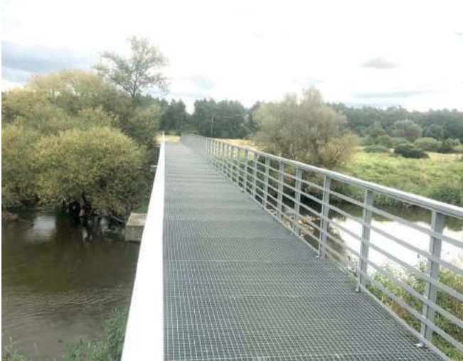
Wyremontowano kładkę na Wieprzu, notorycznie niszczonej przez wandalów. Stare przesła zastąpiły nowe barierki, a na schodach pojawiły się szyny dla rowerów. Całość została też odmalowana - informuje Urząd Miasta Lubartowa
