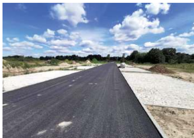
Trwają zaawansowane prace przy rzece Klukówce
