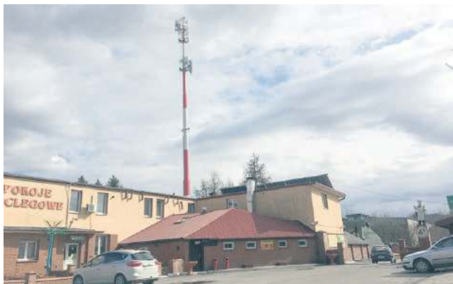
Budowa masztu nie została zakwalifikowana do kategorii inwestycji „mogących znacząco lub potencjalnie oddziaływać na środowisko”.
