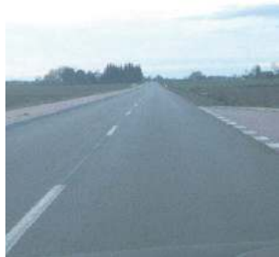
Przebudowa „nadbużanki” obejmie też chodniki.
