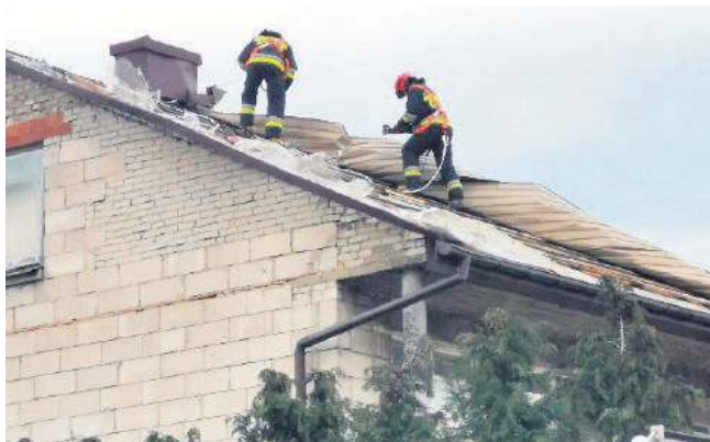
Strażacy zabezpieczyli dach.
