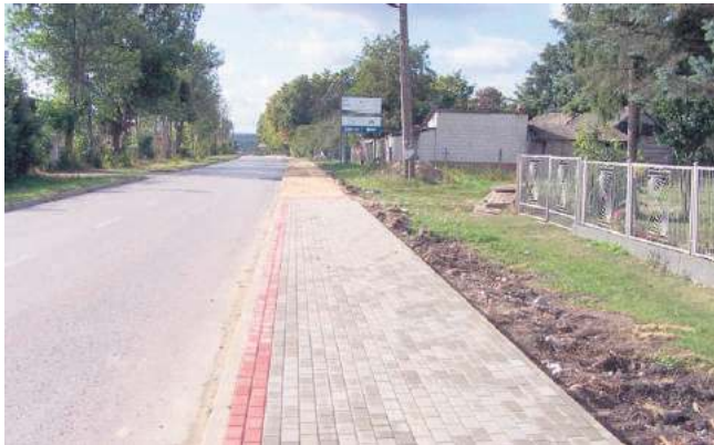
W Turobinie wybudowano chodnik na odcinku 648 m.
