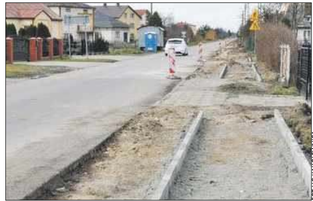
Inwestycja na ul. Południowej ma być gotowa do 31 października
