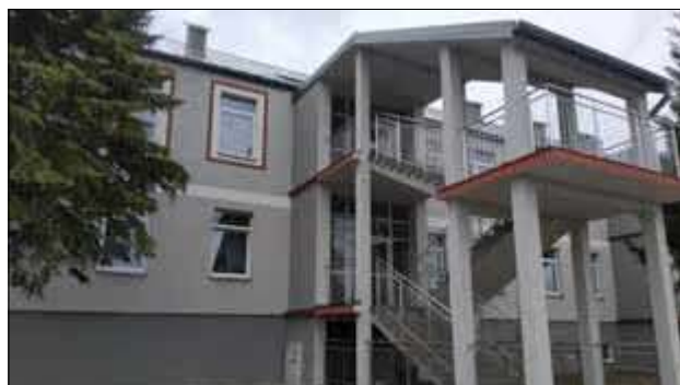
Przy ul. Kościuszki w Janowie Podlaskim, w budynku po dawnym przedszkolu powstało 20 lokali socjalnych
