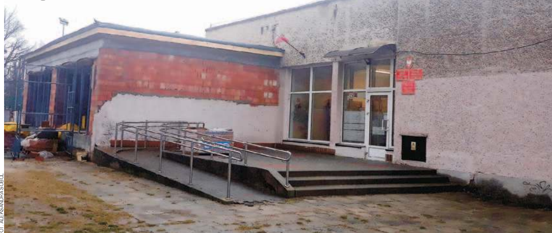
Największa część prac przy remoncie siedziby PIW zostanie wykonana w 2020 roku
