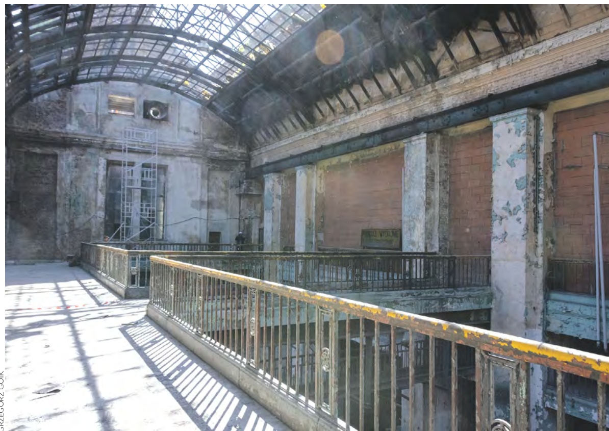
Stare wnętrza elektrociepłowni zyskują nowe funkcje użytkowe
