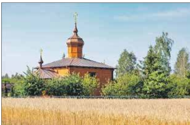
W Dobratyczach w ramach remontu wymieniono szalówkę zewnętrzną i wewnętrzną, wymieniono też konstrukcję dachu, dach pokryto blachą miedzianą, zrekonstruowano też sufit w prezbiterium i w nawie głównej
