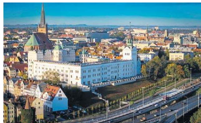
Zastosowana zostanie technologia LED o jednolitej, ciepłej barwie światła
