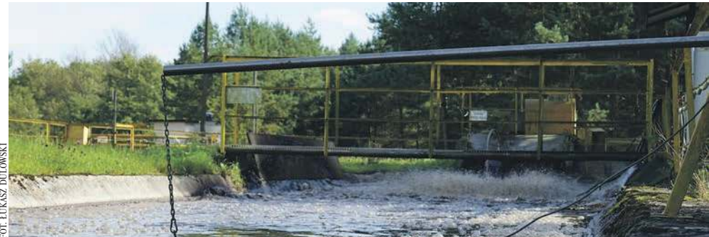
Stara oczyszczalnia ścieków w Alwerni
