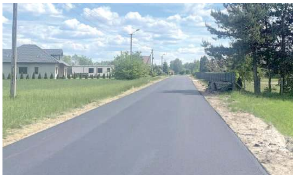
Ułożona została nowa nawierzchnia
