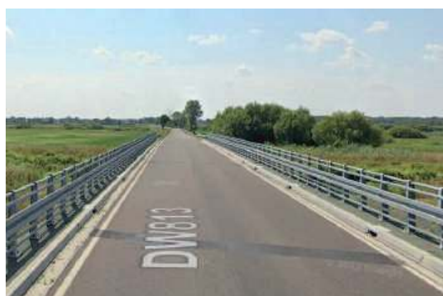
W miejscu obecnego mostu ma się pojawić nowy obiekt
