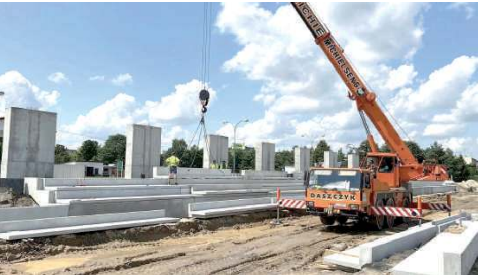
Na stadionie praca wre. Wykonawcą inwestycji jest firma ERES Piotra Szymańskiego
