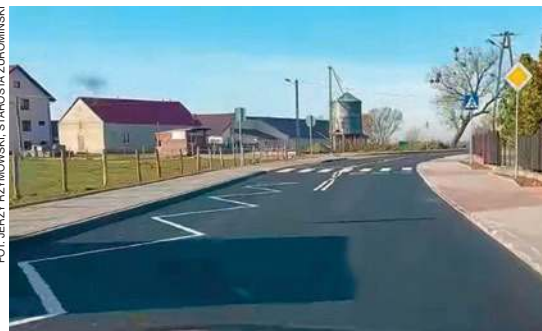
Przebudowana droga w miejscowości Stawiszyn-Łaziska.
