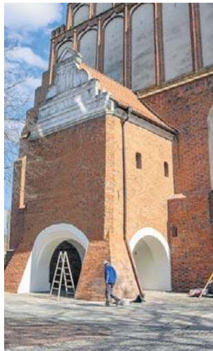
Trwa spory remont bydgoskiej katedry
