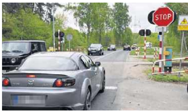
Przejazd kolejowy będzie wyremontowany
