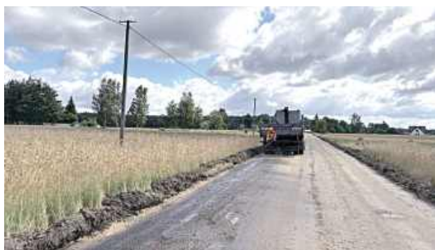
Prace w Antoniówce mają potrwać do końca lipca
