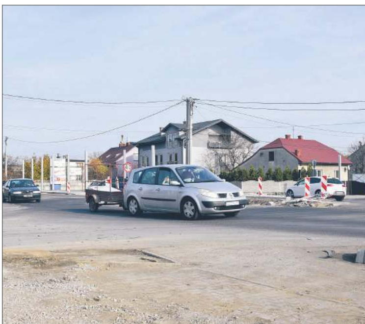
Do węzła autostrady w Pustyni ciężko dojechać. Z jednej strony droga jest zamknięta, z drugiej budowane jest rondo.
