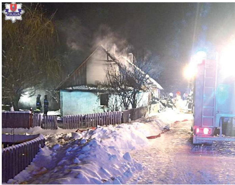
Płonący parterowy dom wykonany był z drewna, ogień strawił prawie cały budynek
