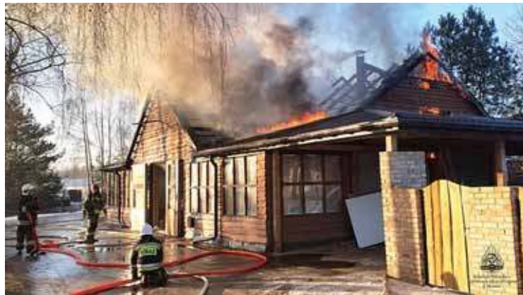
Ogień błyskawicznie opanował cały obiekt
