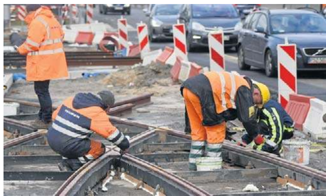
Od 1 sierpnia ruszy remont torowiska ul. Dąbrowskiego
