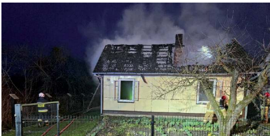
Budynek jest zniszczony w 80 proc. Wstępnie straty zostały oszacowane na około 150 tys. zł
