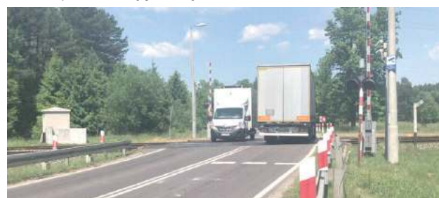
Mieszkańcy Hedwiżyna apelują, by na przejeździe kolejowym w Woli Dużej wybudować wiadukt
