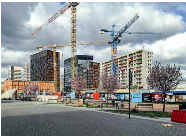
Budowa mieszkań deweloperskich w Łodzi. Kwiecień 2025 r.
