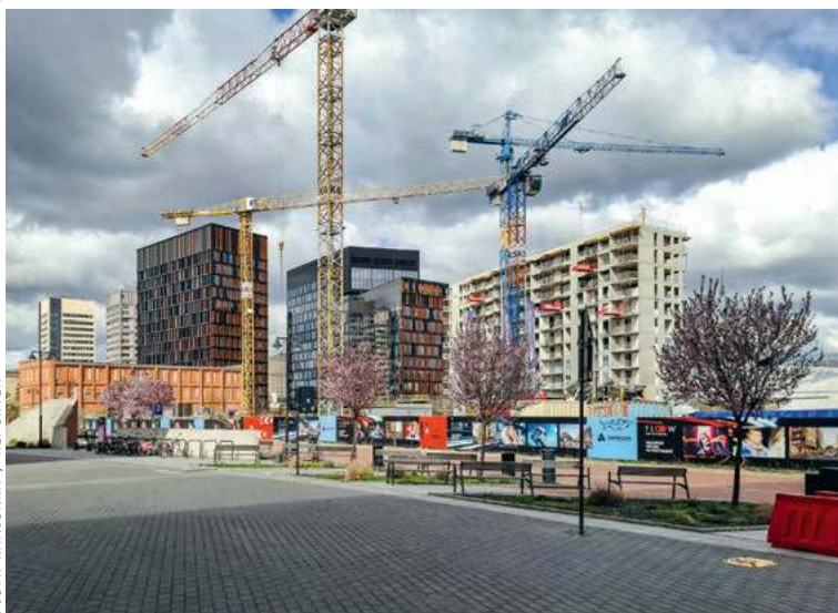
Budowa mieszkań deweloperskich w Łodzi. Kwiecień 2025 r.
