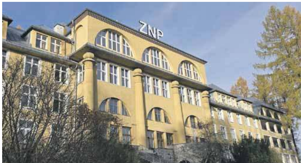
Budynek Sanatorium Nauczycielskiego powstał 100 lat temu
