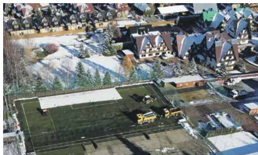
Trwa rozbiórka boiska na Pardałowcu w Zakopanem.
