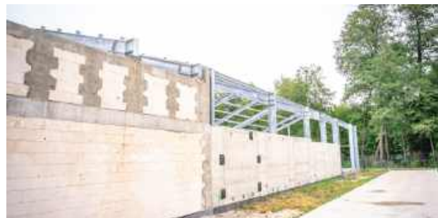
Wkrótce rozpoczną się prace wewnętrzne
