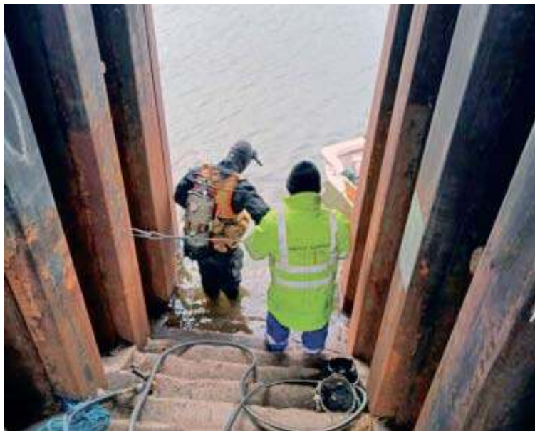
Działania płetwonurków mają na celu wyeliminowanie wycieków z nieszczelnych ścian
