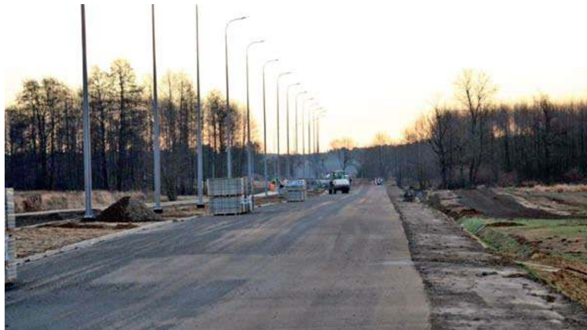
Droga miała być gotowa w połowie roku. Wiele wskazuje na to, że dużo wcześniej będzie oddana do użytkowania (fot. UM w Nowej Soli)
