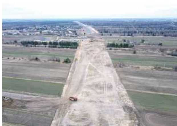
Budowa S19 Lubartów - Lublin. Marzec 2025 r.
