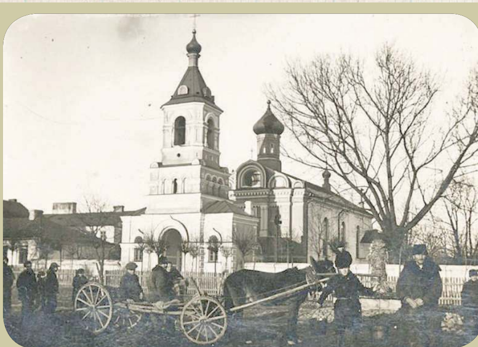
Moskale dokonali przebudowy świątyni, nadając jej cechy klasycznego rosyjskiego stylu - przebudowano fasadę i dobudowano dwie „cebule”, namalowano polichromię i wystawiono dzwonnice bramną. Zmiany te, gdzie to było możliwe, odwrócono w 1923 roku. Zdjęto „cebule” z sygnaturki, zastąpiono ją znacznie lepiej korespondującą z resztą bryły „latarnią”. Zmiany te, gdzie to było możliwe, odwrócono w 1923 roku. Zdjęto „cebule” z sygnaturki, zastąpiono ją znacznie lepiej korespondującą z resztą bryły „latarnią”
