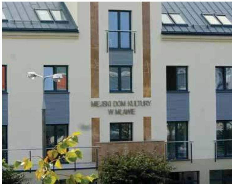
Mieszczące się w MDK kino Kosmos doczeka się gruntownego remontu
