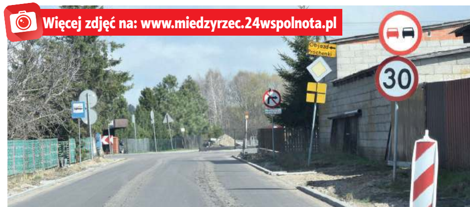
Remontowany odcinek zaczyna się w miejscowości Kożuszki
