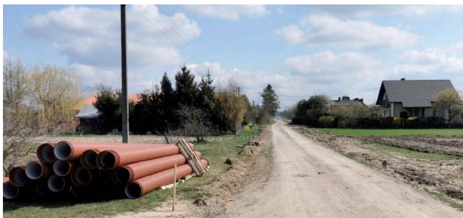
Pierwsze prace przy budowie drogi w Zahajkach rozpoczęły się jeszcze przed świętami
