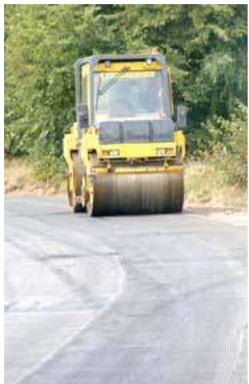
Za około 5 miesięcy zakończy się przebudowa drogi powiatowej w Dobrzanach. Z kolei jeszcze w tym miesiącu poznamy wykonawcę przebudowy drogi w gminie Dolice
