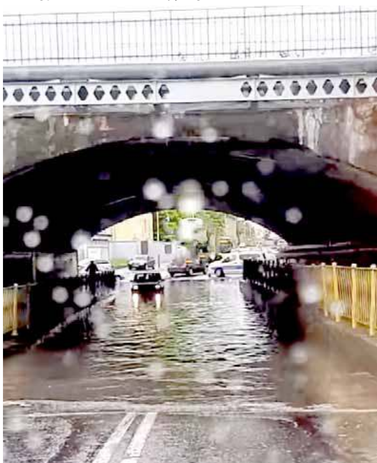
Wiadukt przy dworcu kolejowym
