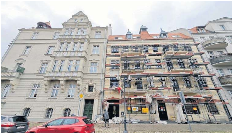
Dawne toruńskie Wilhelmstadt odzyskuje swój dawny blask. Właśnie rozpoczął się remont elewacji kolejnej kamienicy
