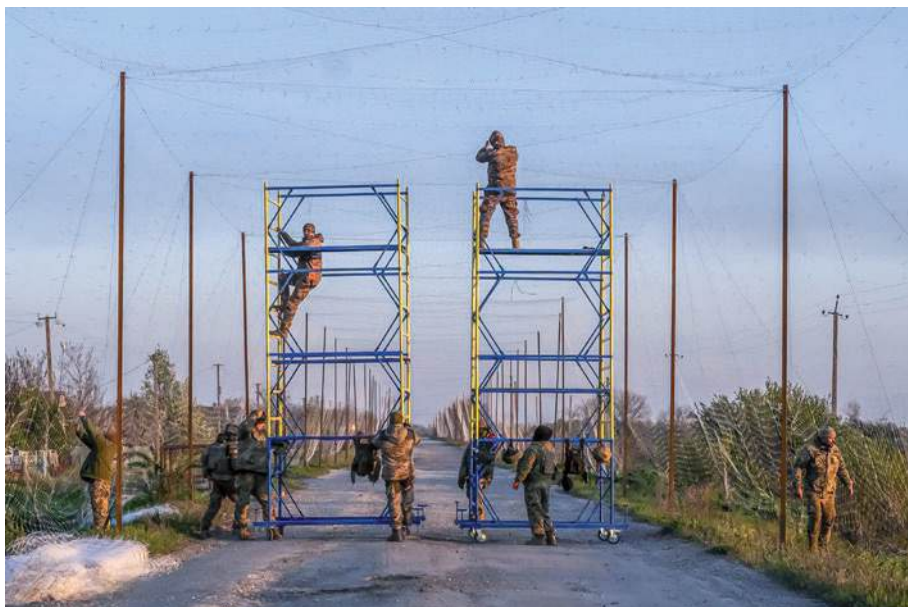
▲ Pasywnym sposobem do ochrony przed małymi bezzałogowcami jest budowa „tuneli” wykorzystujących sieci.
